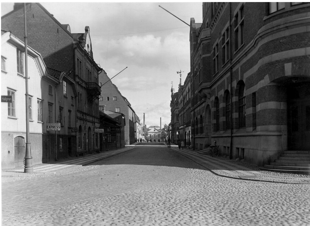
Västerlånggatan 17 Kv Hercules
