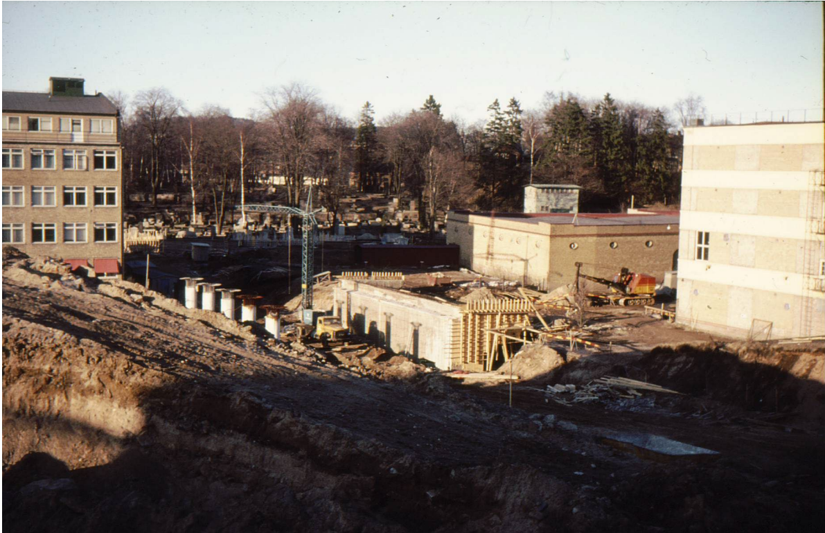
Nu har man schaktat ur en massa och börjat gjuta för motorvägen.
