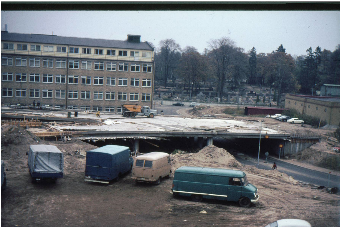
Det börjar ta form med själva vägbanan. Notera dessa vackra arbetsfordon som fanns då.
